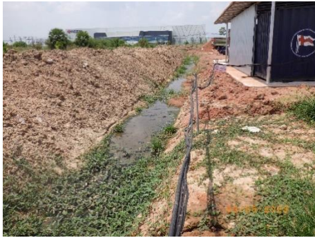
รูปที่ 2-17 รางระบายน้ำและบ่อดักตะกอนดิน
